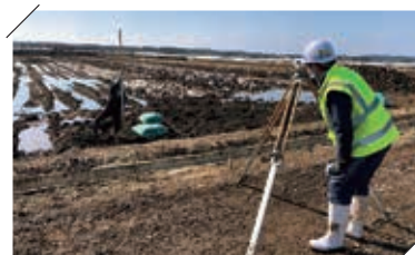
作業現場の一例
