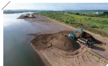
雄物川下流小山下流地区河道掘削外工事
