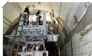
トンネル工事の様子
