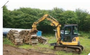
重機を使用しての作業
