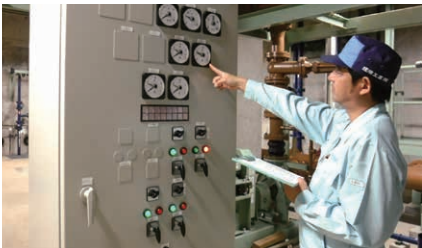
施設維持管理状況
